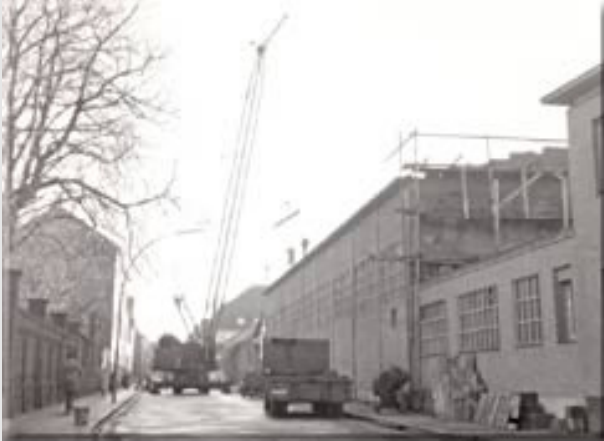
Wiederaufbau 1948 am Standort Dülken Friedrichstraße
